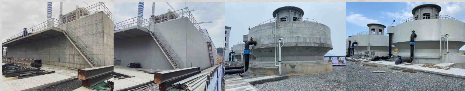
大唐国际新余二期2×1000MW
