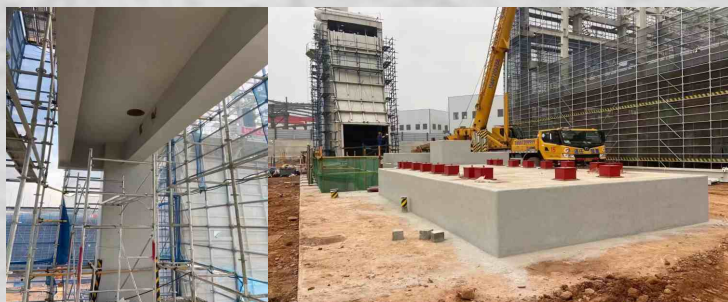
京能宜昌市夷陵区中基天然气热电联产项目
