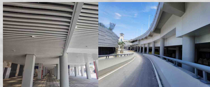
平潭高铁站(福建省优质工程)
