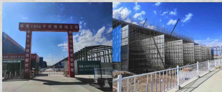
海南±800千伏换流站工程
