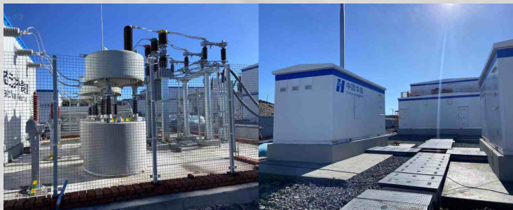
内蒙华能风电升压站基础
