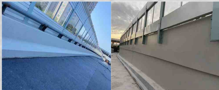
福建福州工业路混凝土处理
