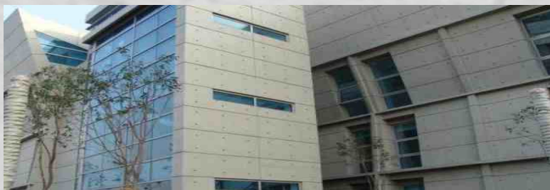
全透明施工法
