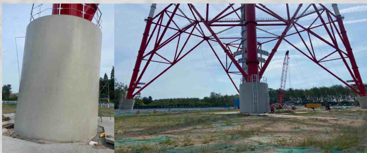
螺山长江特高压铁塔
